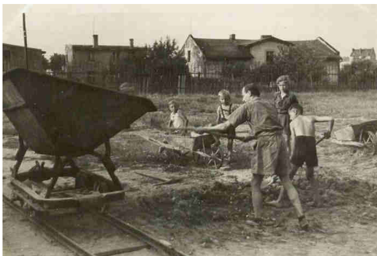
Fot. 1. Niwelacja terenu budowy Domu Harcerza. W tle dom rodzinny dh. Teodora Krügierra na ul. Bonin
